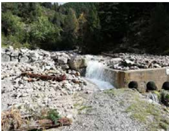
Fotografia 7. Detall del pas de la pista per la llera de Carboners. L'aigua va circular per damunt de la pista, deixant-la impracticable. Foto de Marta Domènech
