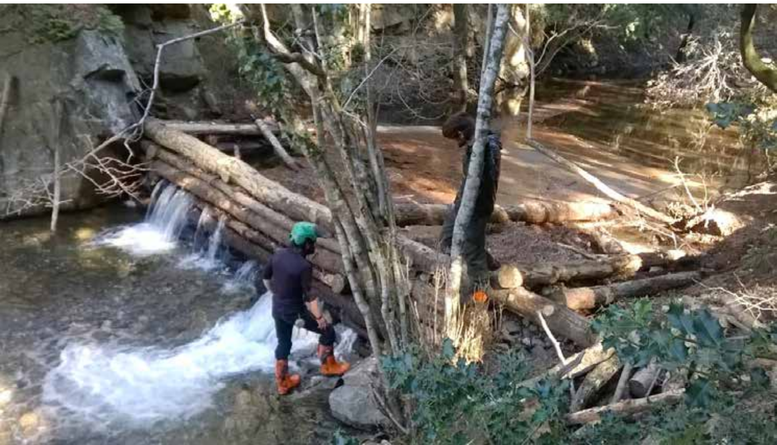
Fotografia 18. Vista del aterrament del dic fet amb fusta de castanyer. Foto d'Andreu González
