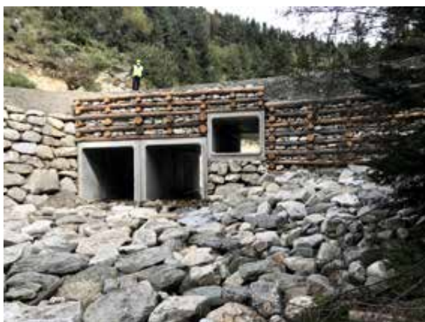
Fotografia 15. Vista general de l'obra des d'aigües avall. Foto de Montserrat Solanelles
