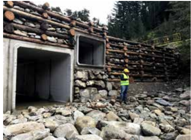
Fotografia 14. Col·locació dels troncs cap i cuats per tal d'equilibrar l'estructura. Foto de Montserrat Solanelles
