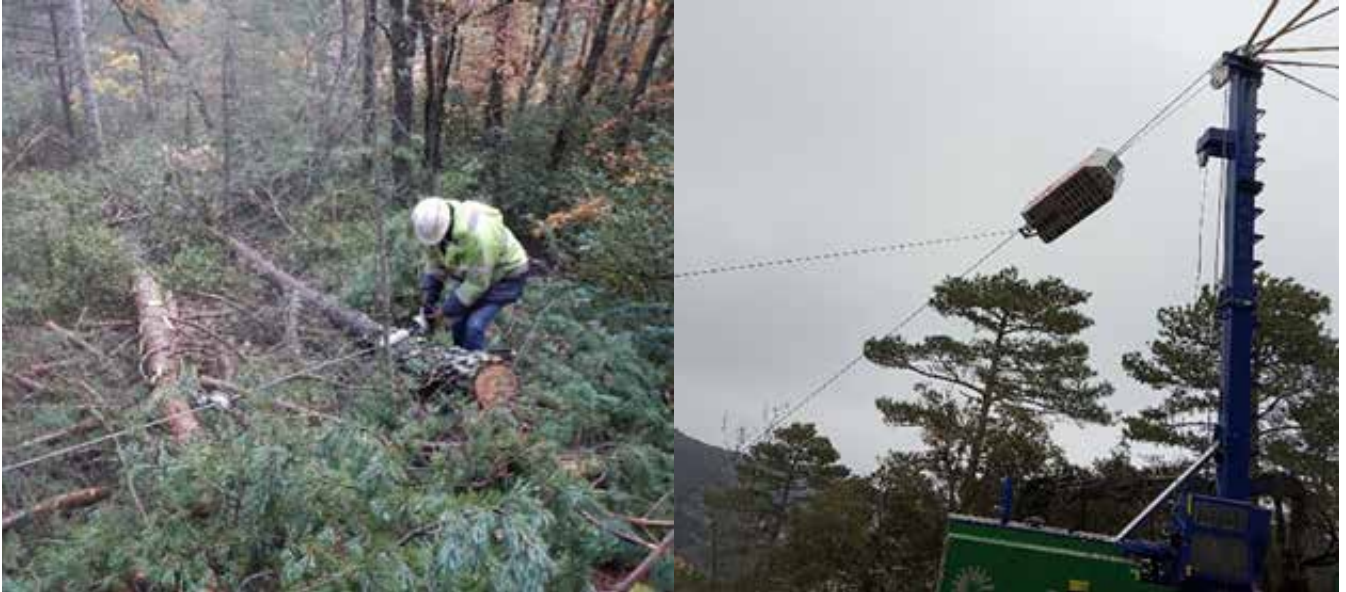
Fotografies 4 i 5. Operari lligant els arbres amb el sistema de chokers (esquerra) i posició del carro durant el viatge lateral (dreta).
