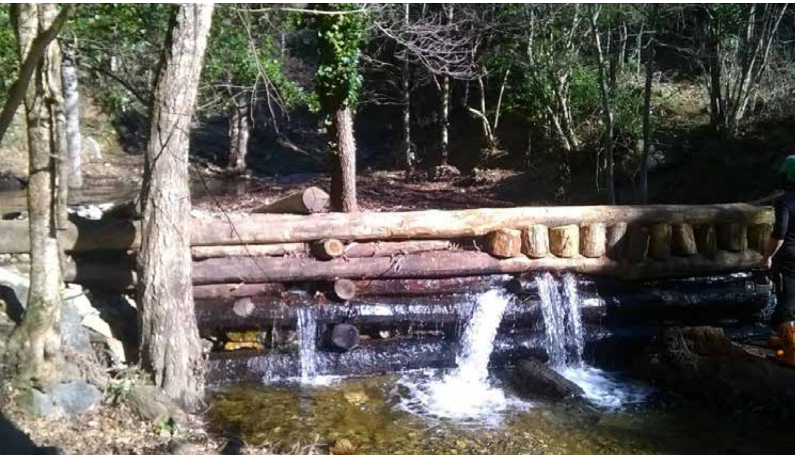
Fotografia 17. Vista frontal del dic fet amb fusta de castanyer. Foto d'Andreu González
