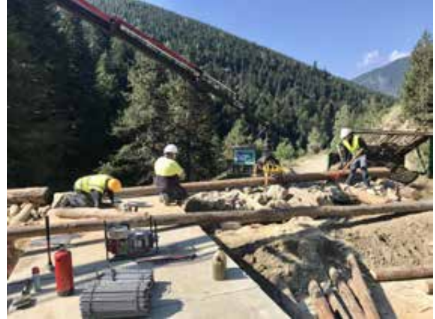
Fotografia 12. Selecció dels troncs i prova de muntatge de l'estructura. Foto de Montserrat Solanelles
