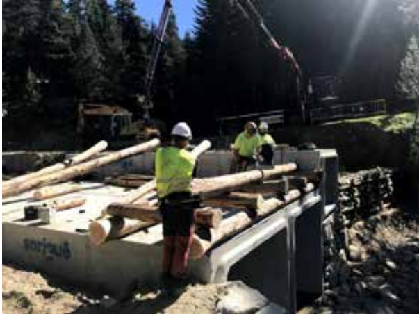
Fotografia 11. Realització d'entallades per tal de que tots els punts de contacte treballin. Foto de Montserrat Solanelles
